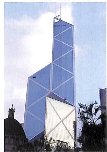
中国銀行。70階建てのタワービル
