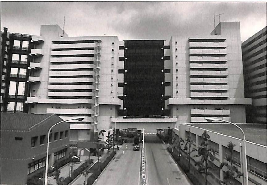
ブリッジシャッターが閉まったところ。一階道路部分は、災害時にはスプリンクラーにより散水する。写真右、通常はシャッターが開いている
